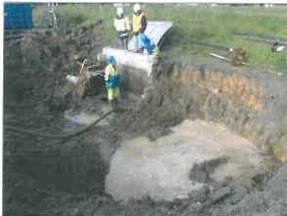
Pompage et nettoyage du réservoir de 80 m 3 GO/GNR
