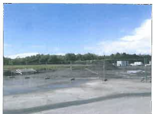
Fin du remblaiement et compactage des fouilles
