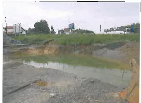
Remplissage de la fouille lors des intempéries
