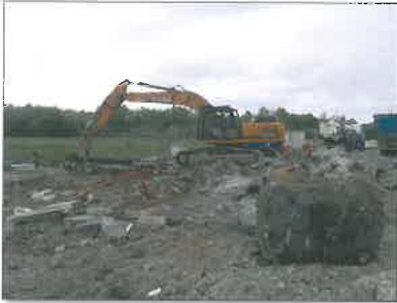
Démolition de la piste de distribution
