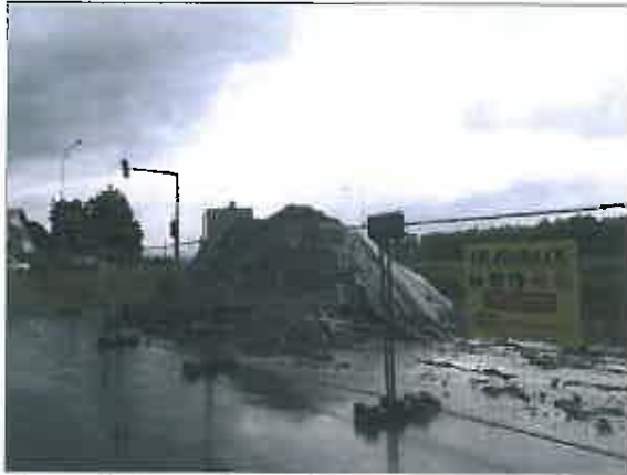
Stockage des terres impactées sur et sous bâche et mise en sécurité du site
