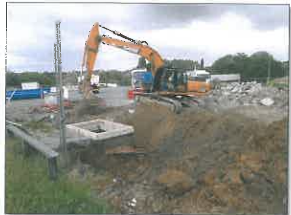
Extraction du séparateur à hydrocarbures
