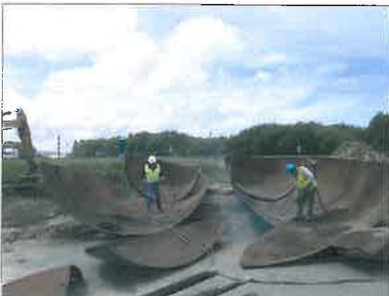
Découpage du réservoir et évacuation de la ferraille
