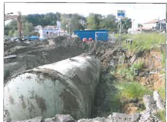
Extraction du réservoir de 80 m 3 GO/GNR
